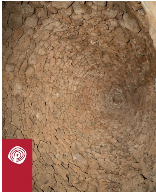
Orroli, Nuraghe Arrubiu. La copertura a tholos all'interno della torre centrale del nuraghe.
